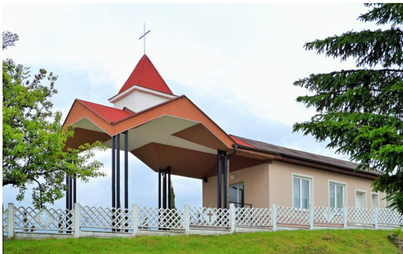
Dom smútku po rekonštrukcii
